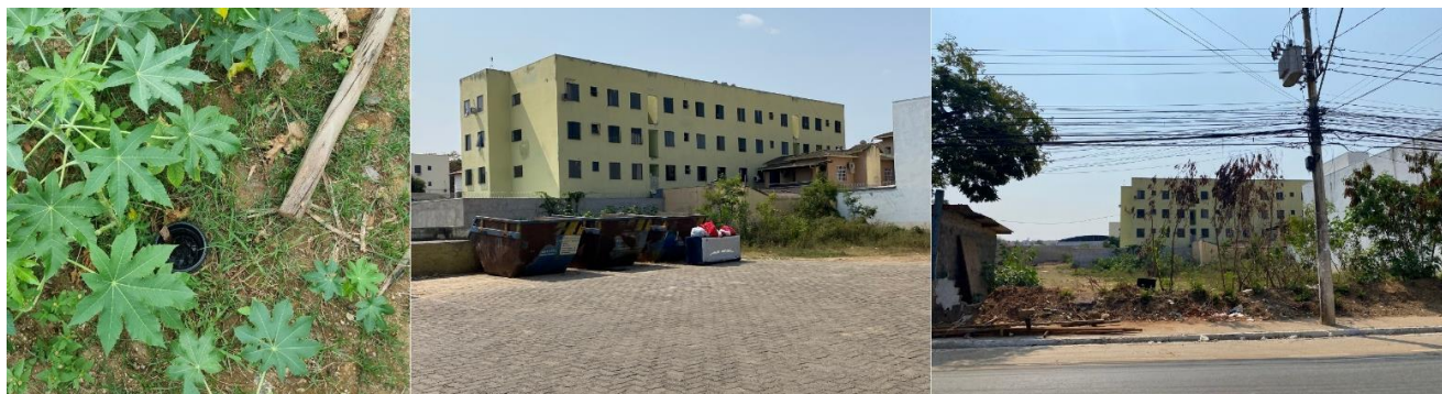
Figura 4 - Fotografias do Ecoponto do bairro São Pedro em Governador Valadares. As imagens referem-se à presença de vegetação oriunda da falta de limpeza adequada no local, armazenamento inadequado de resíduos e descuido com o local. Fonte: Os autores
